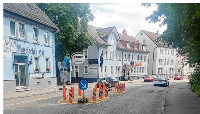
Diese temporäre Querungshilfe für Fußgänger gibt es seit ein paar Tagen in der Bahnhofstraße in Crailsheim. Foto: Ralf Mangold
